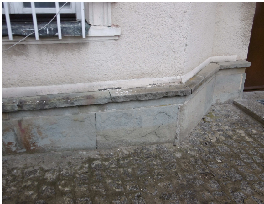
Fot Nr 7 Zniszczony cokół w elewacji zachodniej
