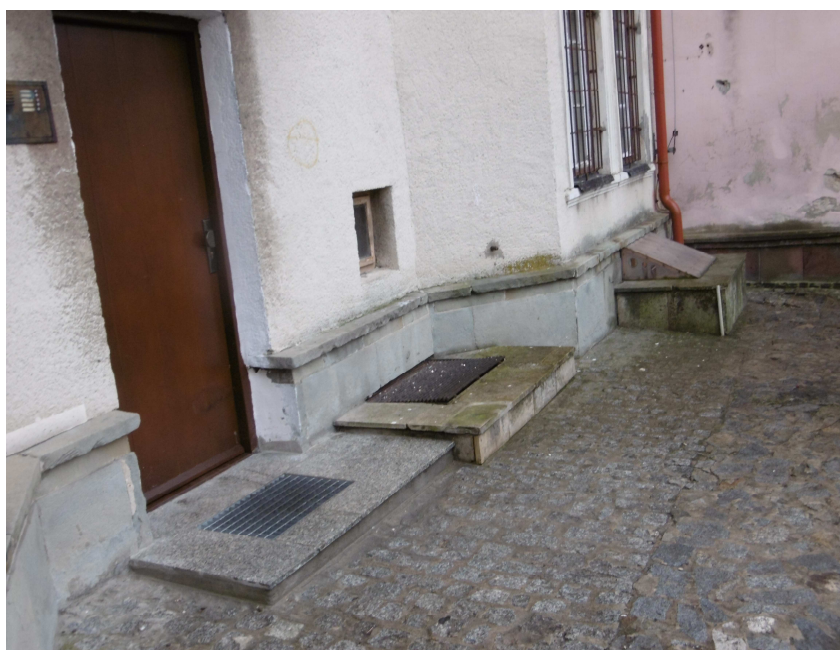
Fot. Nr 4 Spocznik wyłożony płytkami lastrykowymi - do wymiany na płytki kamienne ; obudowa szachów płytkami kamiennymi .
