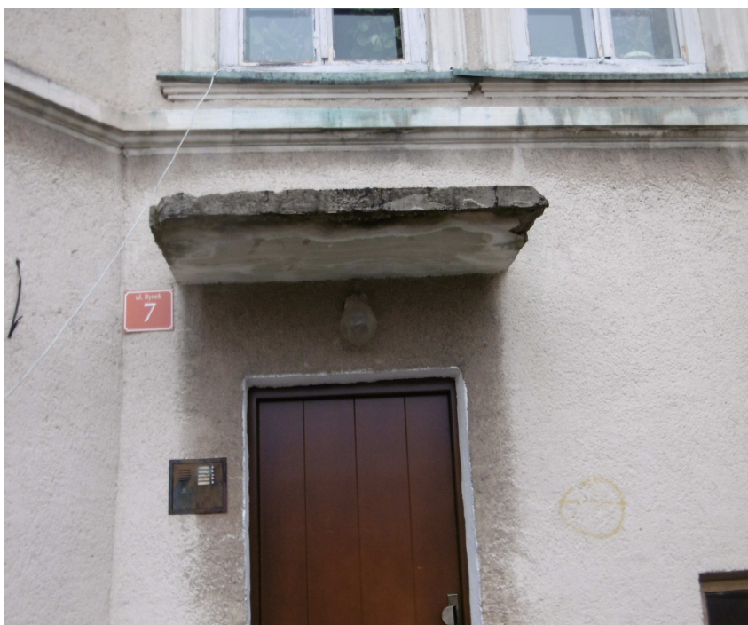
Fot Nr 8 Zniszczony daszek przy wejściu do klatki schodowej w elewacji zachodniej
