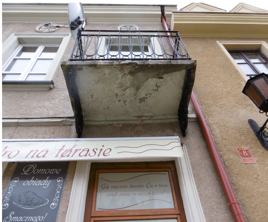
Fot Nr 6 Zniszczona płyta balkony w elewacji wschodniej
